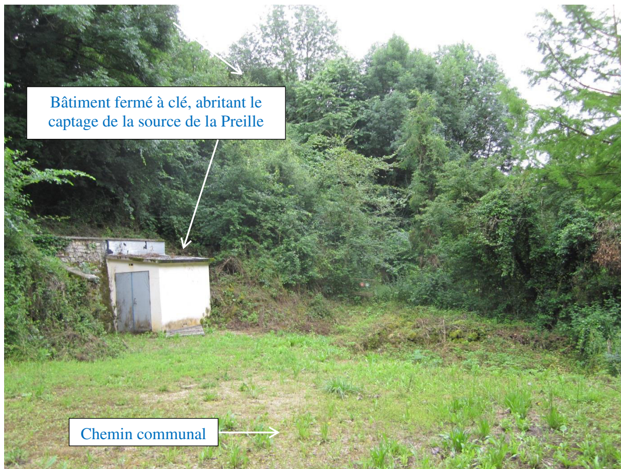
Photographie n° 1 : photographie du captage de la source de la Preille (prise de vue : Terraqua le 25/06/2012)
